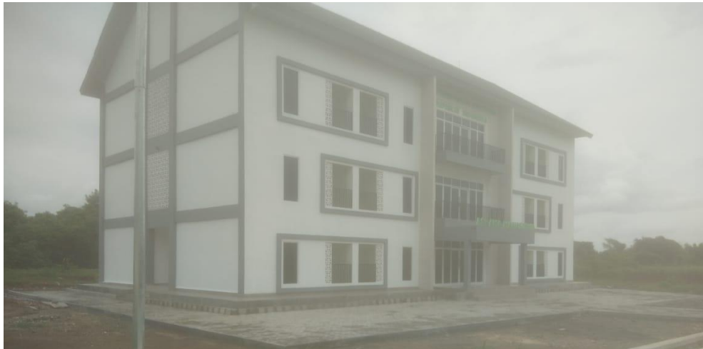
Gambar 7. Gedung asrama mahasiswa Poltekkes Kemenkes Banten
